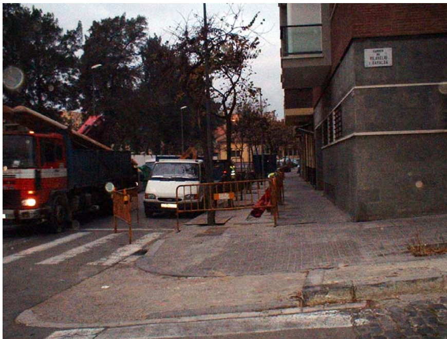
Fotografia 1: Vista general del carrer de la Mare de Déu de Port en el seu tram afectat per l'obra.
